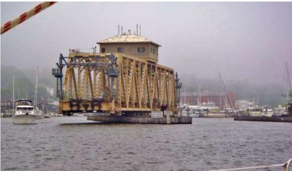
Die altherwürdige Eisenbahndrehbrücke, über hundert Jahre alt, aus genieteten Stahlträgern errichtet liegt kurz vor der weitaus
